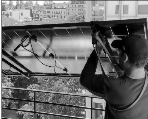
Ein Steckersolargerät (Balkonkraftwerk) wird am Halleschen Ufer installiert.
