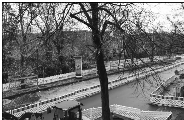
Beidseitige Baustelle in der Blücherstraße.
