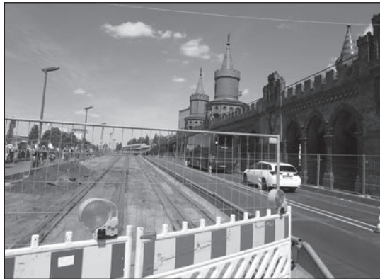
ENGE OBERBAUMBRÜCKE: Bis November wird die Fahrbahndecke erneuert. Foto: psk
