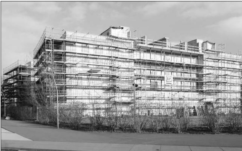
HOFFUNG AM GLEISDREIECK. Nach monatelangem Stillstand geht es auf der Baustelle am zukünftigen Möckernkiez nun endlich weiter.
