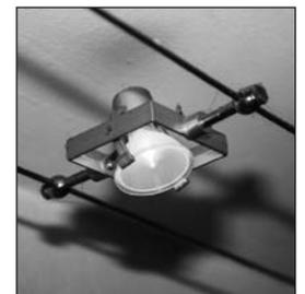
*STROMFRESSER: Halogenleuchten sollten durch LED-Technik ausgetauscht werden.*
