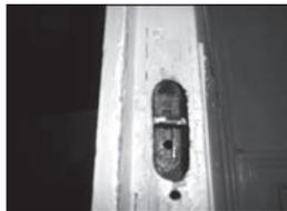
**EINE SCHRAUBE** am Riegel des Standflügels würde ein »Riegelziehen« verhindern. Foto: rsp
