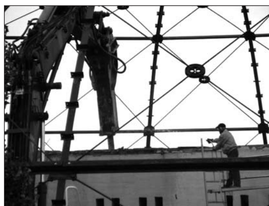
MENSCH UND MASCHINE: Bauarbeiter bindet Staub mit einem Wasserschlauch. Foto: Hanna Siehr
