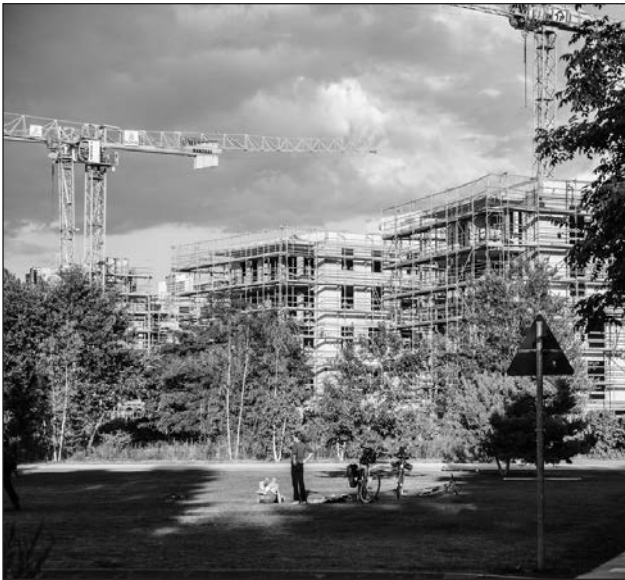
ALLE KRÄNE STEHEN STILL, wenn die liebe Bank es will. Beim Bauvorhaben Möckernkiez geht nichts mehr.
