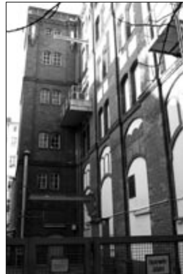
VERSTECKT IM HINTERHOF: Umspannwerk Zossener Straße.
