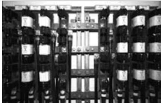
TRAFOHÄUSCHEN VON INNEN: Von hier gehen die Leitungen zu den Hausanschlüssen. Foto: Vattenfall
